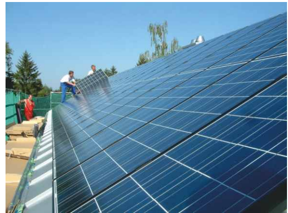
Installation einer PV-Anlage
